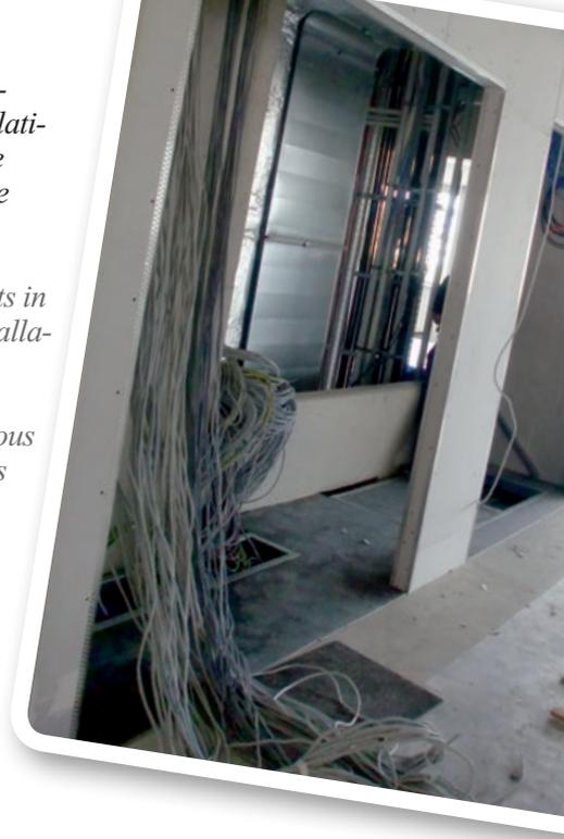
*Risiko: Offene Kabelschächte in der Installationsphase; gefährliche Brandlast durch große Mengen an Kabel – anonymes Beispiel*
